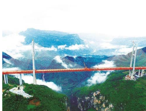
北盘江大桥-世界第一高桥
