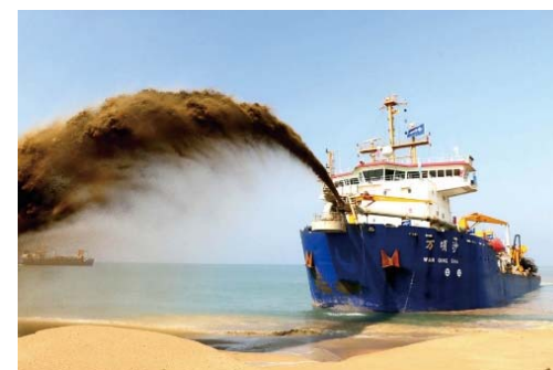
“万顷沙”在科伦坡港口城施工
