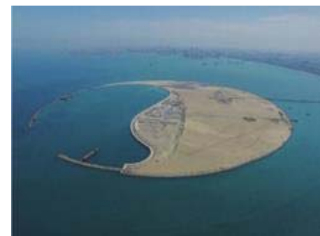
南海明珠人工岛二期工程
