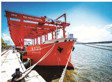
英国利物浦二期自动化码头岸桥
